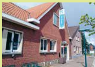
OC De Zolder Kwerpsebaan 251 3071 Erps-Kwerps
