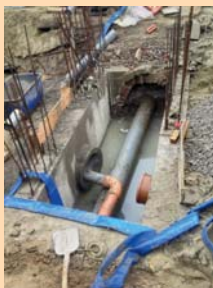
De Weesbeek onder het wegdek van de Dekenijstraat werd volledig afgekoppeld van afvalwater en kreeg een nieuwe bedding in beton. De rode buis rechtsonder op de foto voert regenwater aan van omliggende woningen en de slidders in de straat. De grote grijze buis in het midden van de beek was een tijdelijke verbinding om de Weesbeek stromend te houden tijdens de werken.
