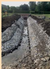
De Weesbeek in de Kasteelstraat werd geheerprofileerd met schanskorven.
