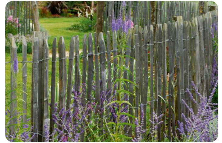
8 Kastanje hekwerk (h:1m latafstand 4-5cm)
