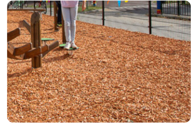
1 Gekeurd houtsnippers voor speelpleinen (afboording in staal)
