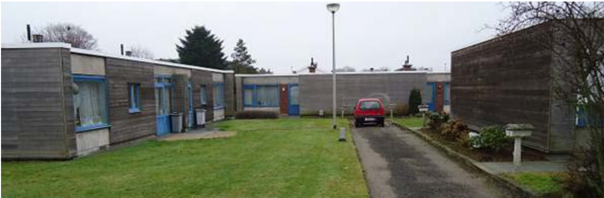
Vernieuwde bejaardenwoning langs de Curegemstraat
