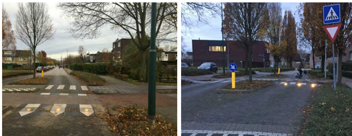
Figuur 118: led signaleringssysteem oversteekplaats Moerdijk, Nederland (bron: https://www.sysconnect.nl/ )
