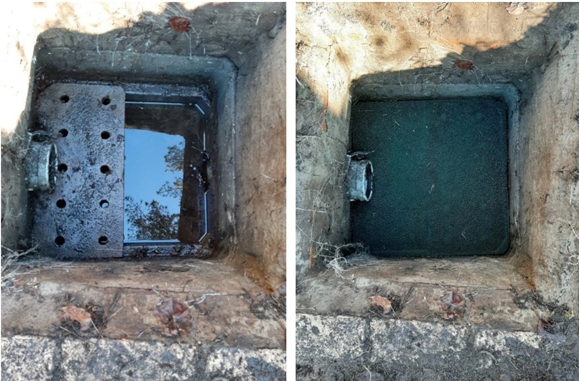
Figuur 8: aansluiting van een hemelwaterput met controleput en terugslagklep
