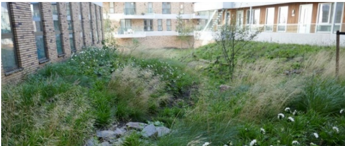
Figuur 19: Infiltratiebekken in IJburg van Hollandsgroen
