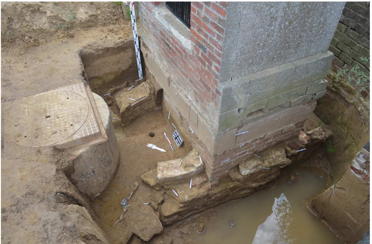
Figuur 2. De Kruisborrekapel is gebouwd op een waterput (borre). Deze waterput werd bij de aanleg van een riolering reeds deels vernield. (Foto: W.Sevenants)
